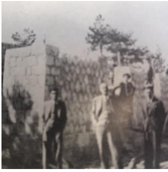
Οι εργασίες κατασκευής
